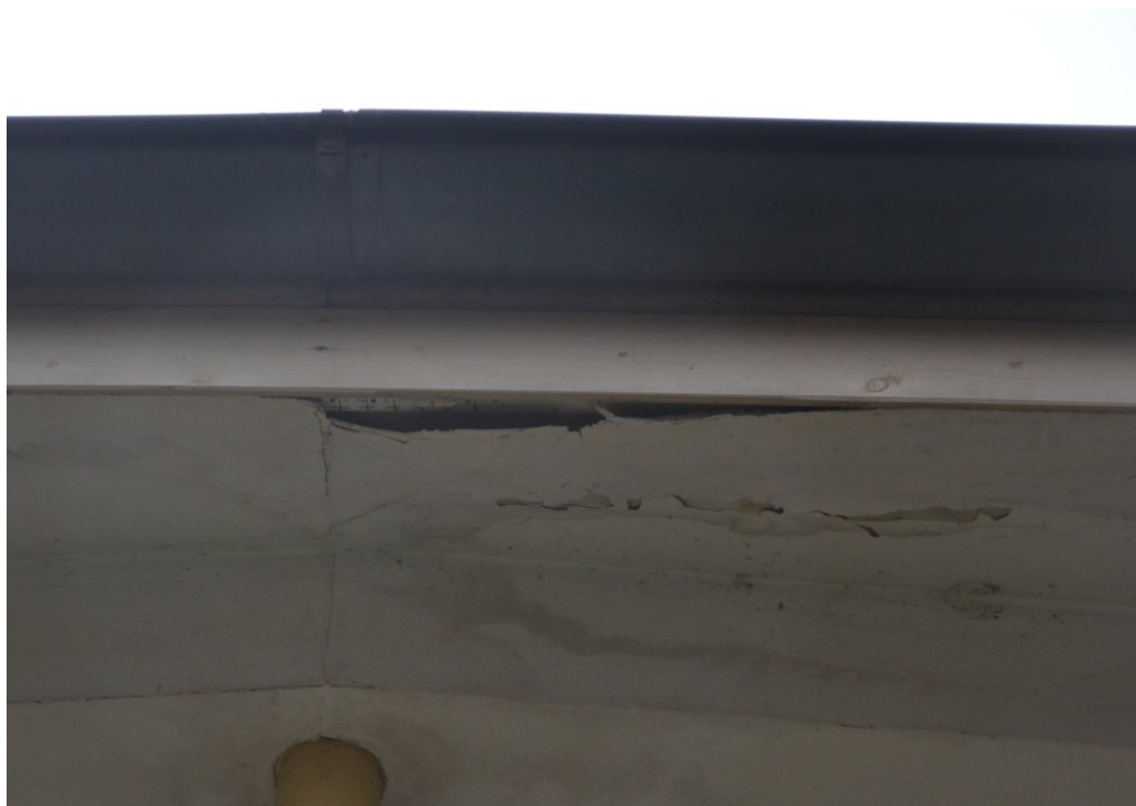
Obr 6: Drobné poruchy omítky jsou patrné zejména v kruhové části budovy.
